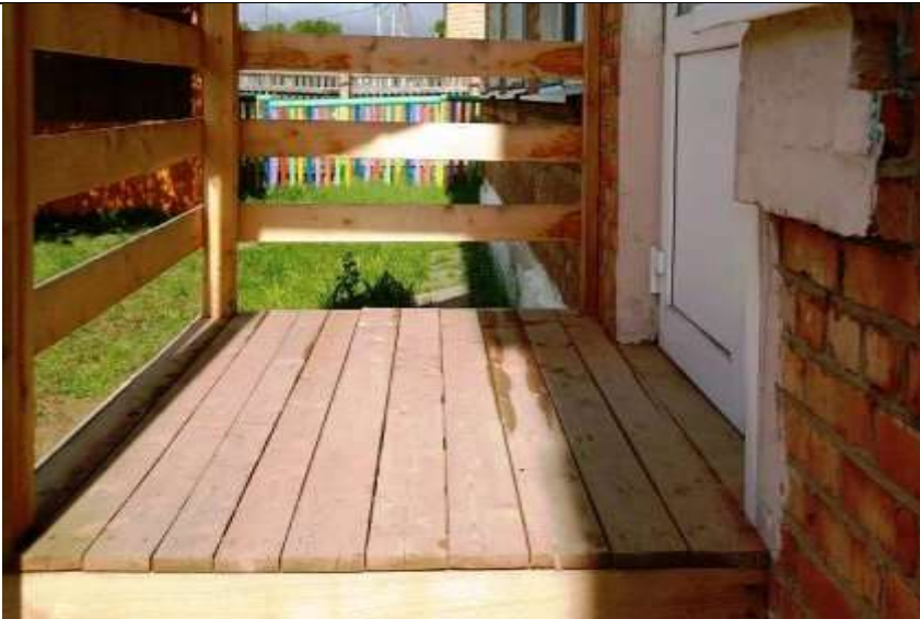
№ 19, входная площадка входа №3
