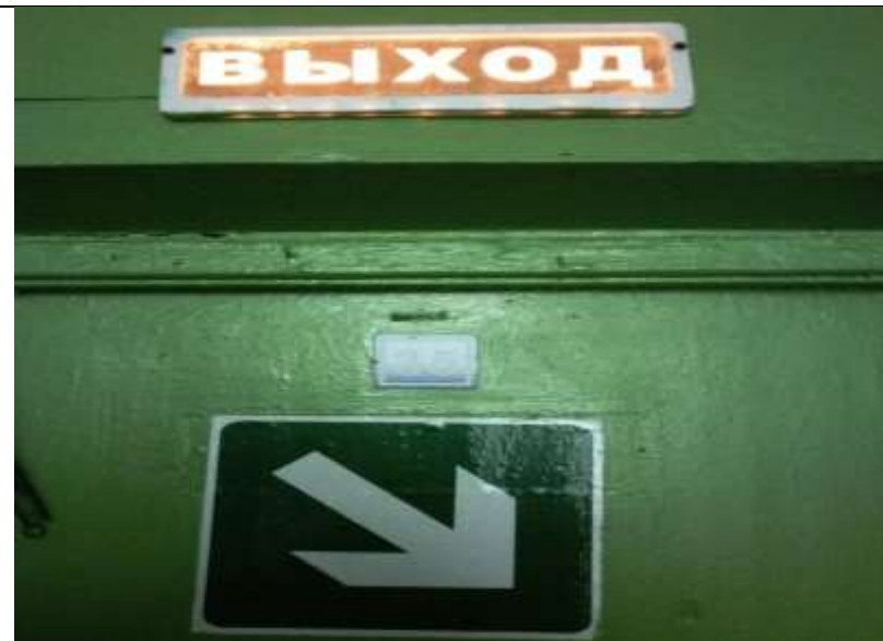
№ 66, Визуальные средства путей эвакуации
