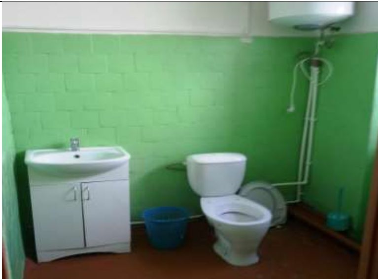
№59, санузел для учащихся, 1 этаж, школа
