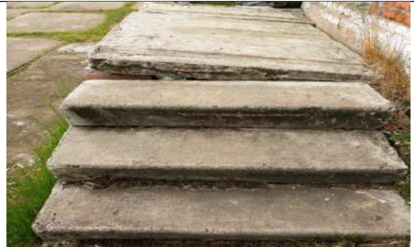
№ 18, запасной выход №6, лестница
