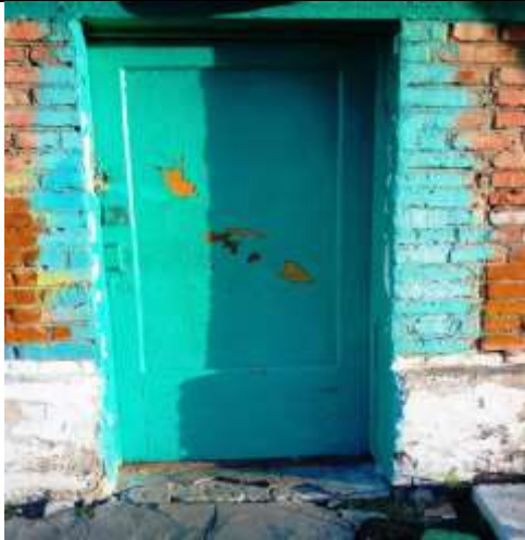
№23, дверь с площадкой входа №5
