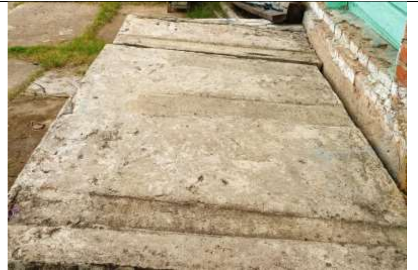
№20, входная площадка входа №6
