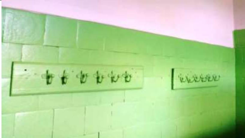
№65, раздевалка при спортзале, школа, 1 этаж
