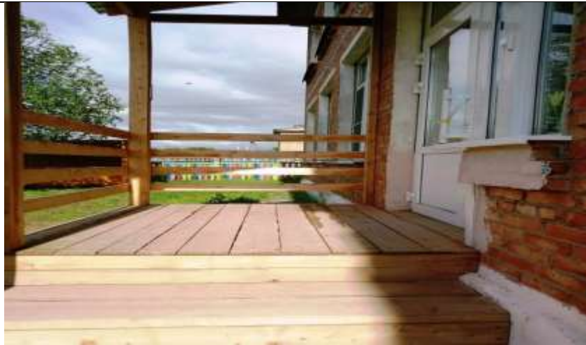
№ 17, запасной выход №3, лестница
