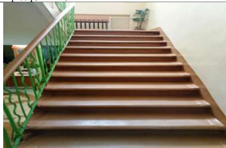
№ 35, лестница, 1 этаж, школа
