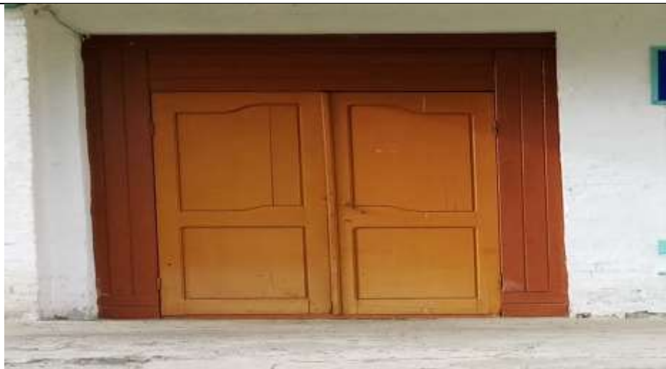
Фото №11, дверь наружная школа
