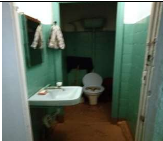
№56, санузел для персонала, 1 этаж, школа
