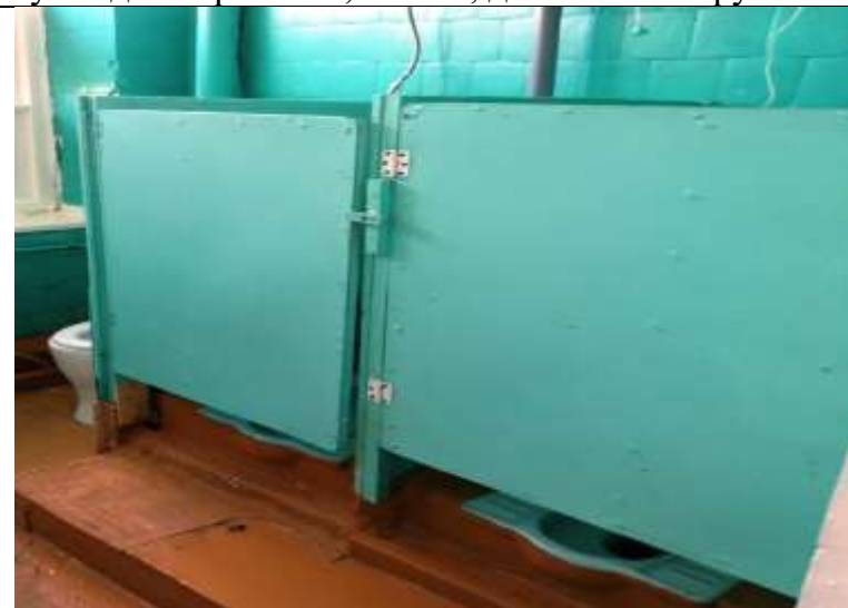
№59, санузел для учащихся, 1 этаж, школа
